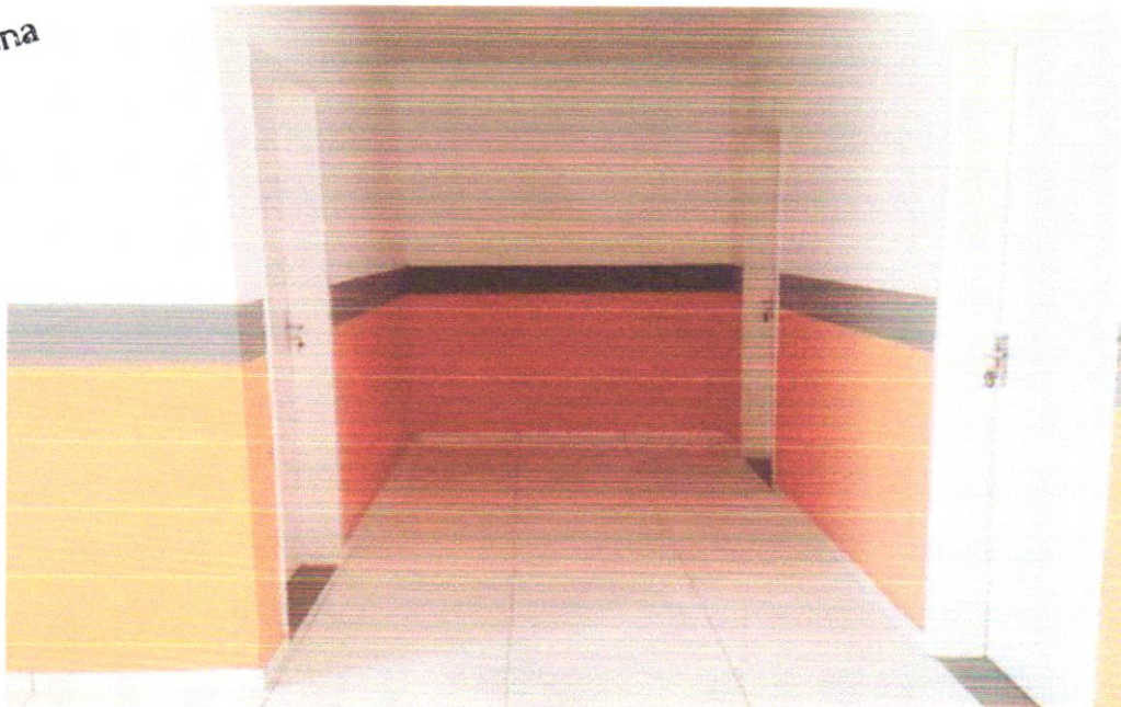
FOTO 06 - APLICAÇÃO MANUAL DE PINTURA COM TINTA LÁTEX ACRÍLICA EM PAREDES, DUAS DEMÃOS. AF_06/2014
