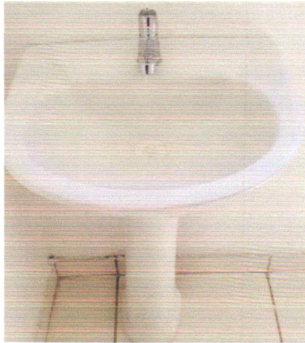
FOTO 15 - LAVATÓRIO LOUÇA BRANCA COM COLUNA, 45 X 55CM OU EQUIVALENTE, PADRÃO MÉDIO - FORNECIMENTO E INSTALAÇÃO. AF_01/2020
