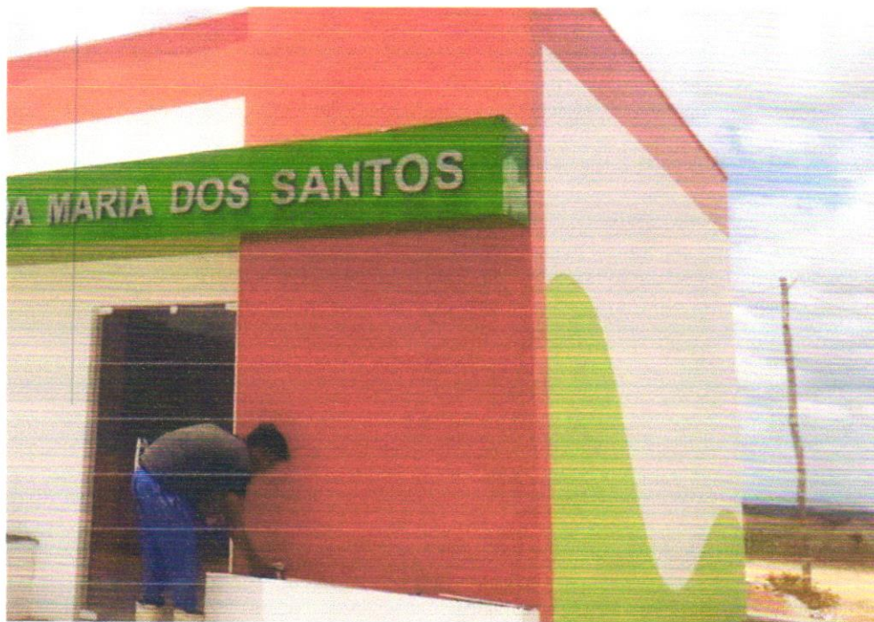
Foto 20 - APLICAÇÃO MANUAL DE PINTURA COM TINTA LÁTEX ACRÍLICA EM PAREDES, DUAS DEMÃOS. AF_06/2014
