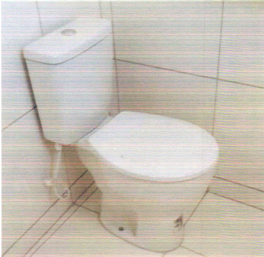
FOTO 17 - VASO SANITARIO SIFONADO CONVENCIONAL COM LOUÇA BRANCA - FORNECIMENTO E INSTALAÇÃO. AF_01/2020
